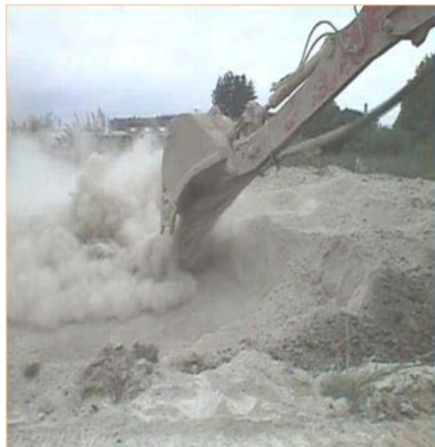
Foto 2: Aplicación de estabilización/solidificación en operación continua utilizando retroexcavadora y reactivos en seco.
